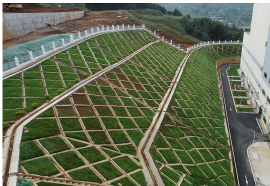
坡顶及坡面排水沟
